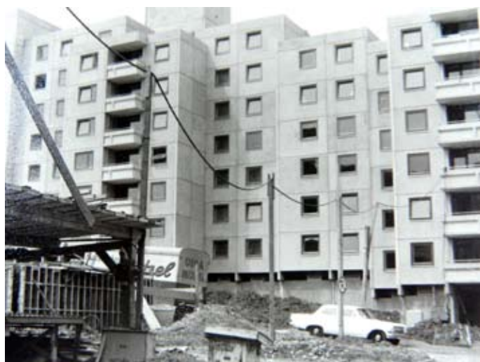
Die ersten Bewohner beziehen die Baustelle
