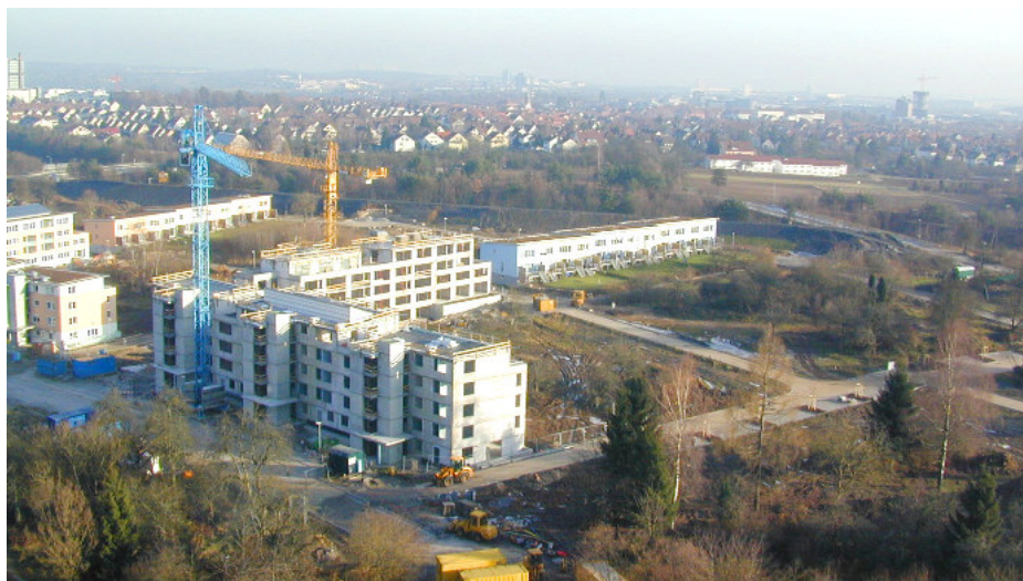
Zweite Bauphase in den Lauchäckern am 14.12.2002
