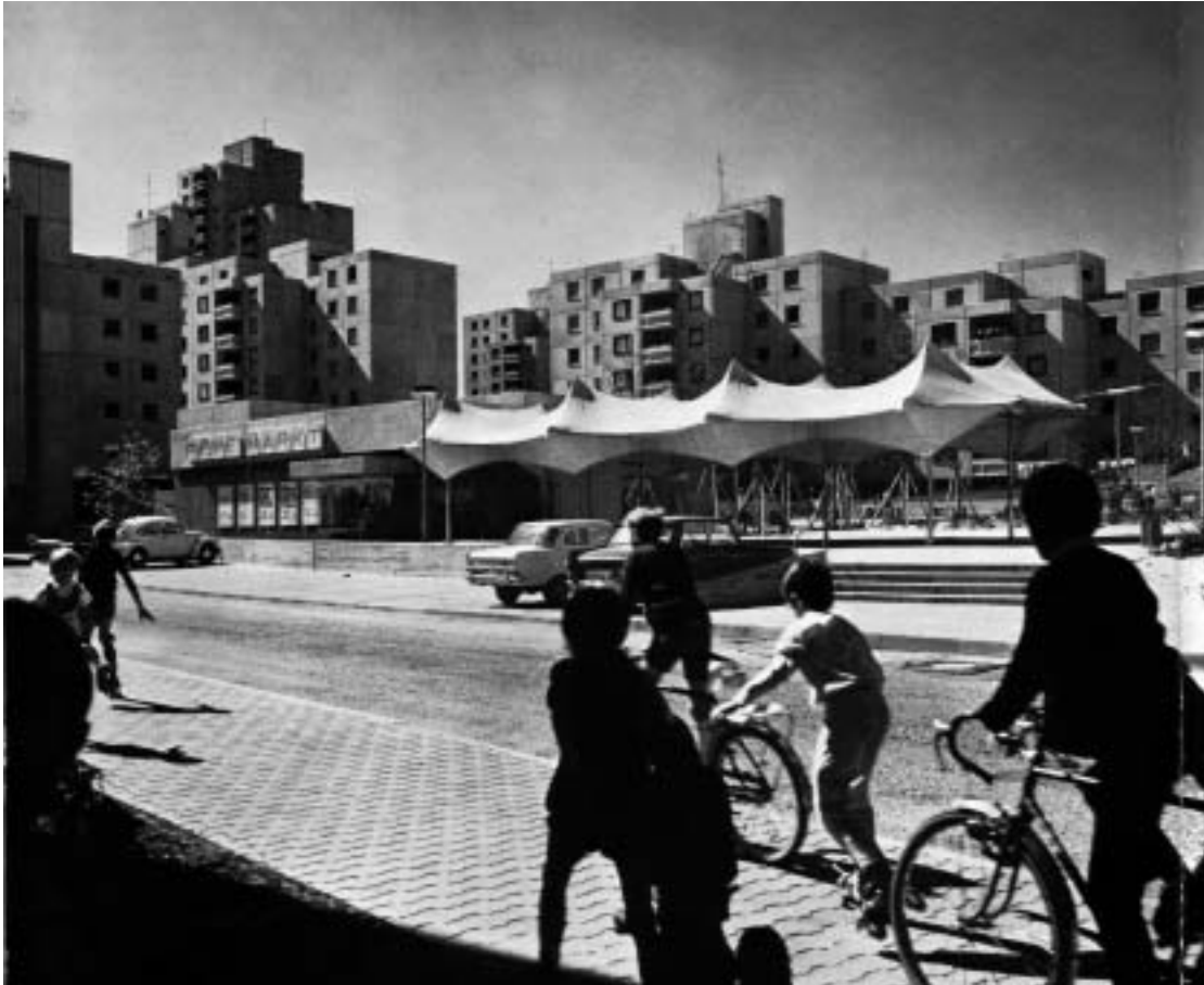
Im Lauchhau 12 - Jugendräume, Ladenzentrum und ein kleiner teilüberdachter Platz um 1972 (Diese wurden im Rahmen der zweiten Nachverdichtung 1997-1998 aufgegeben.)
