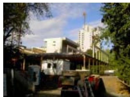
05.10.2006: Das Obergeschoß wird gebaut.
