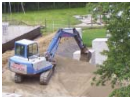
06.06.2006: Die Betonfundamente werden ...
