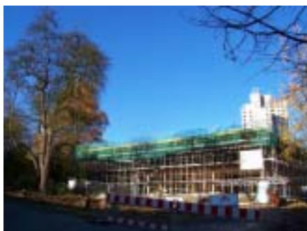
18.11.2006: Warten auf die Fassade.
