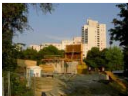
27.07.2006: Der zentrale Mittelteil wird weiter betoniert.
