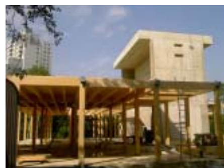
27.09.2006: Der Holzbau entsteht.
